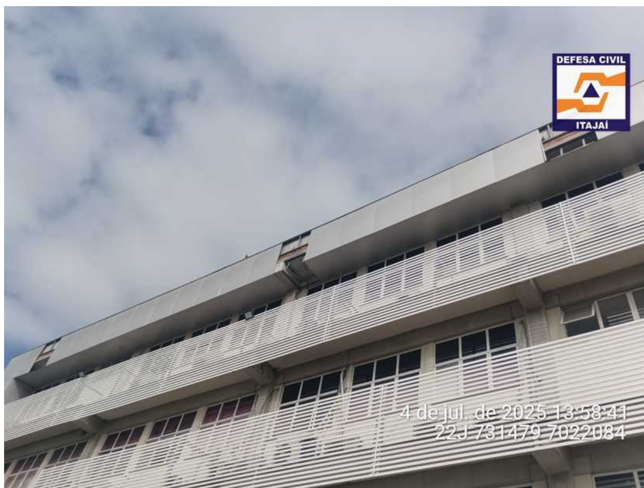
Figura 08 - Vista de pontos onde ocorreu a queda do revestimento com placas de alumínio - ACM (a).
