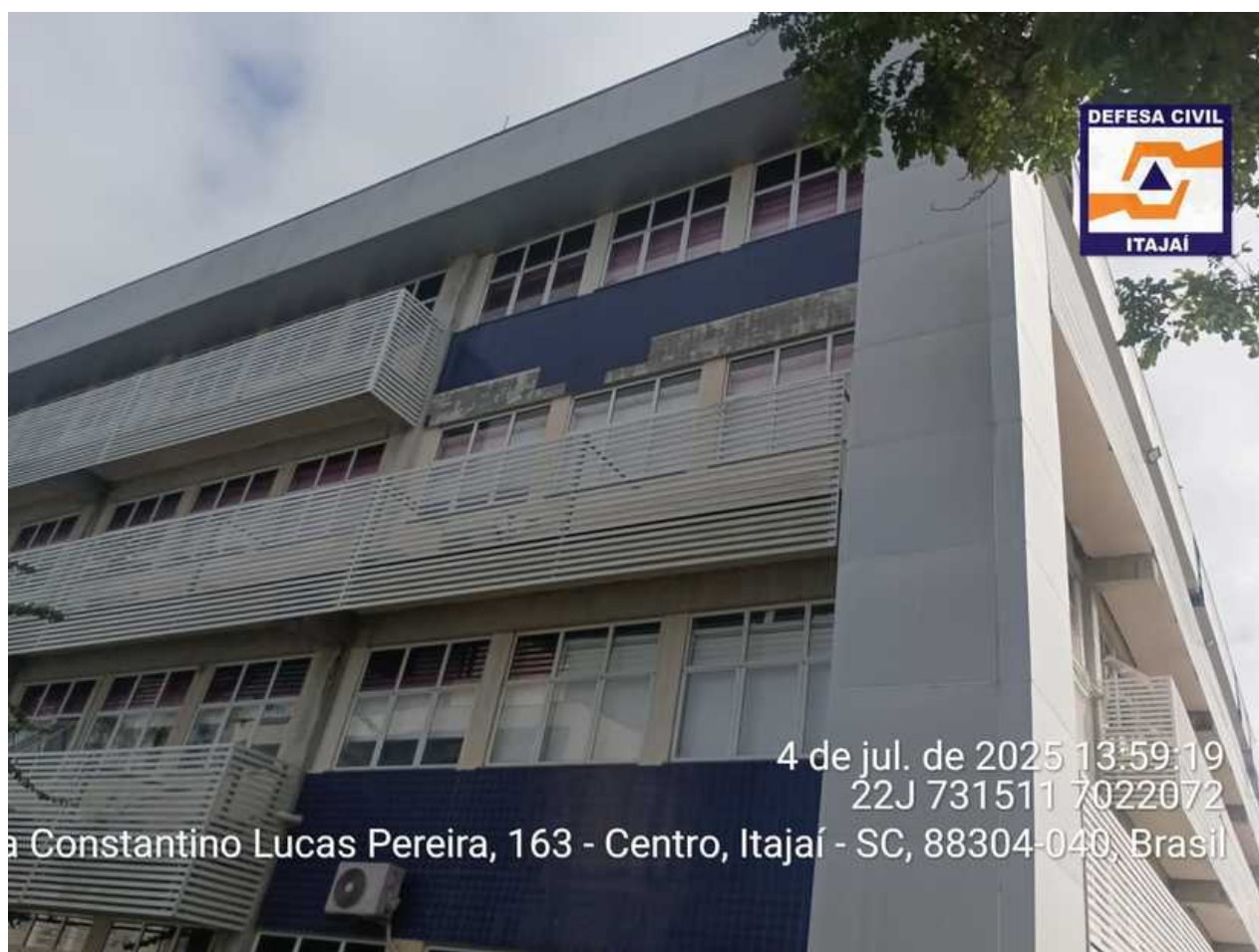
Figura 02 - Vista de área onde o revestimento de pastilhas cerâmicas está se desprendendo (a).
