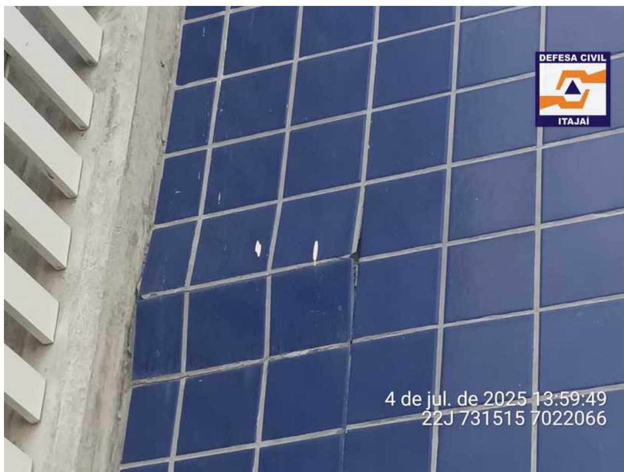
Figura 05 - Vista de pontos onde o revestimento cerâmico está estufado, oferecendo risco de queda (a).
