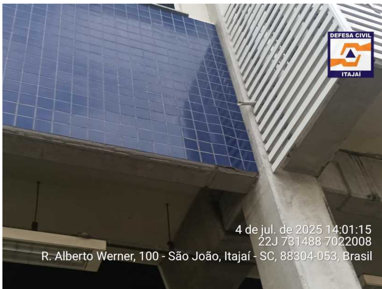
Figura 07 - Vista de pontos onde o revestimento cerâmico está estufado, oferecendo risco de queda (b).
