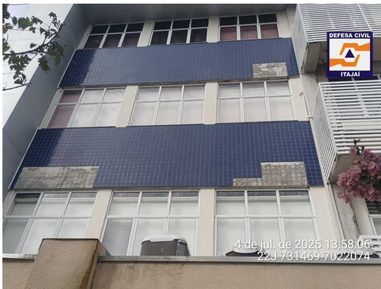
Figura 03 - Vista de área onde o revestimento de pastilhas cerâmicas está se desprendendo (b).
